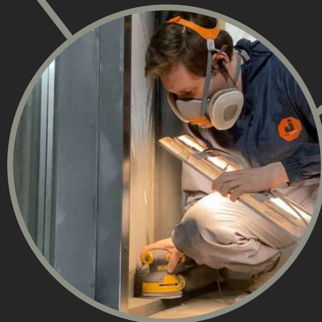
шлифование поверхности, удаление старого слоя краски
