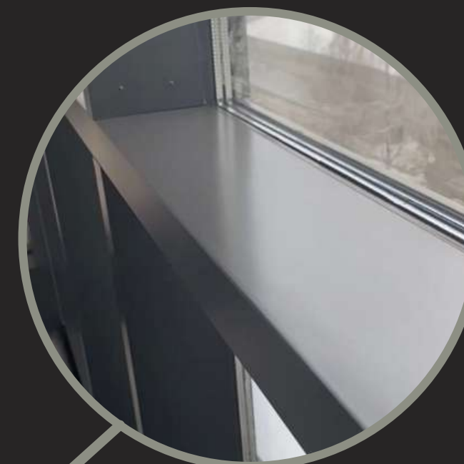
окраска отреставрированной поверхности
