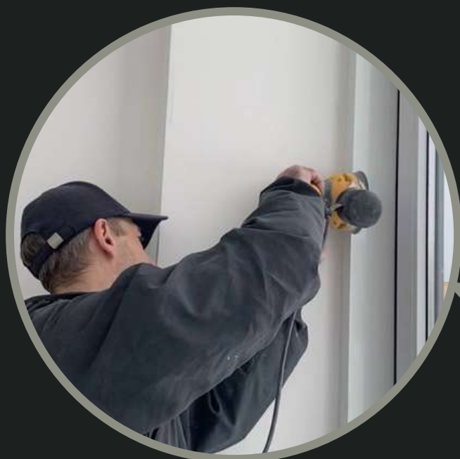
ремонт и реставрация оконного профиля
