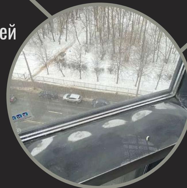
маскировка отверстий шпаклевкой
